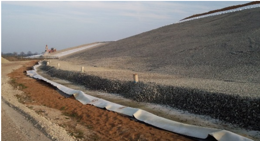
Abbildung 1: Aufbau einer mineralischen Entwässerungsschicht
