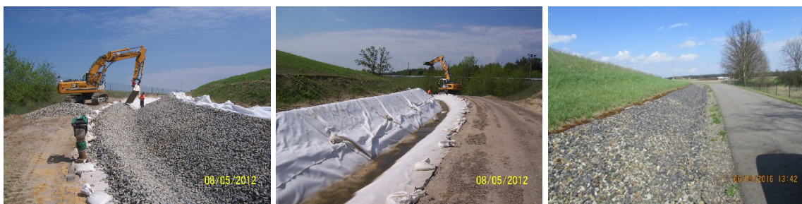
Abbildung 14: Deponie Spremberg-Cantdorf: Herstellung des Oberflächenwasserableitgraben
