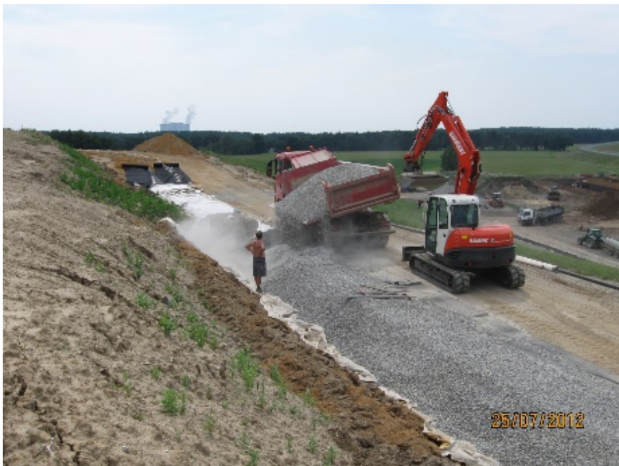
Abbildung 12: Deponie Spremberg-Cantdorf: Einbau der Versickerungsrigole auf dem Deponiekörper
