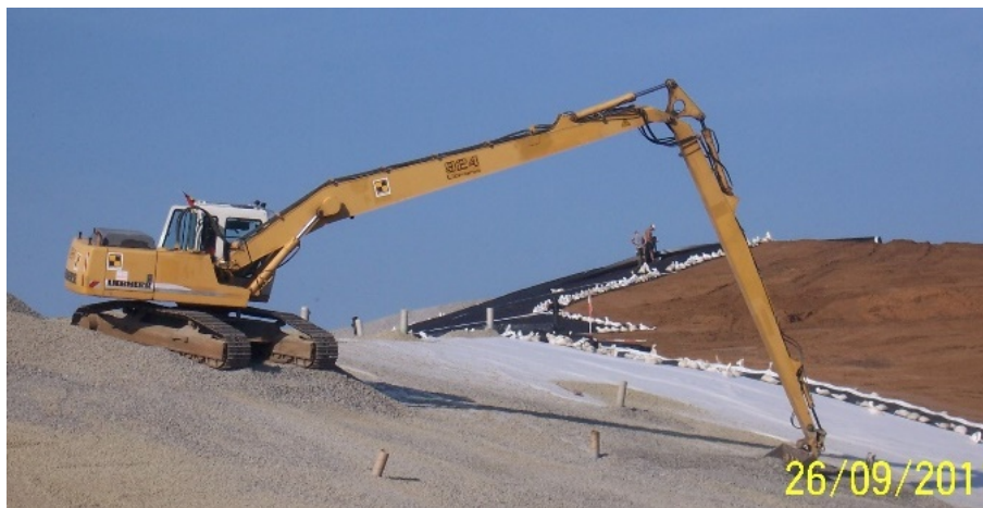
Abbildung 3: Einbau der mineralischen Entwässerungsschicht mittels Langarmbagger
