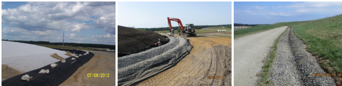
Abbildung 13: Deponie Spremberg-Cantdorf: Herstellung der Versickerungsrigole auf dem Deponiekörper
