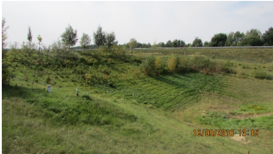
Abbildung 15: Deponie Spremberg-Cantdorf: Bepflanzung des Versickerungsbeckens
