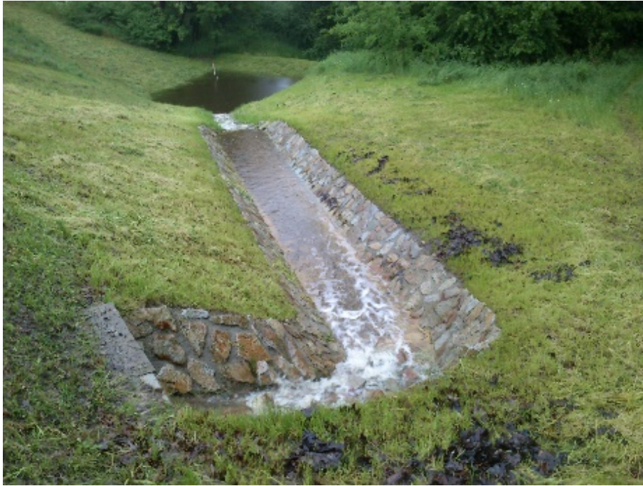
Abbildung 10: Deponie Spremberg-Cantdorf: Aus Naturstein gemauerte Absetzanlage
