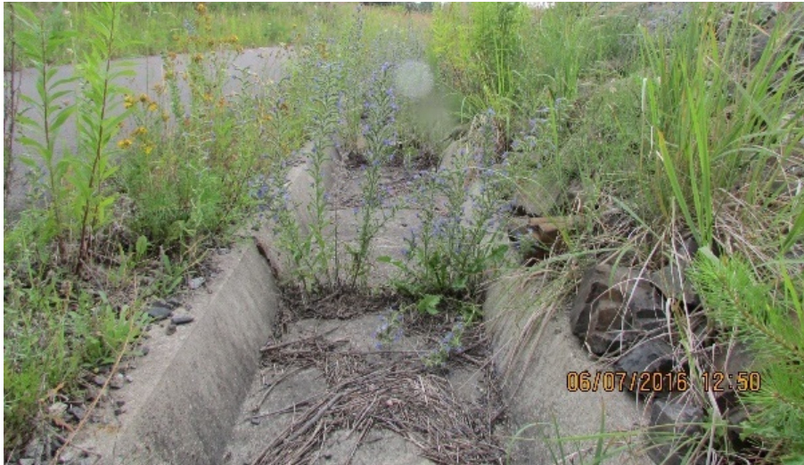
Abbildung 7: Teilweise zugewachsene Betonkaskade einer Betriebsdeponie
