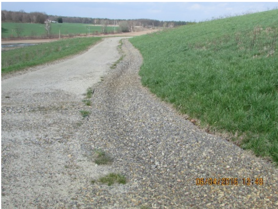
Abbildung 8: Deponie Spremberg-Cantdorf: Aus Schotter aufgebaute Versickerungsrigole auf dem Deponiekörper
