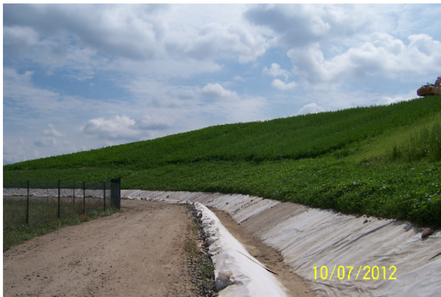
Abbildung 4: Schutz der fertiggestellten Entwässerungsgräben durch Vliesabdeckung
