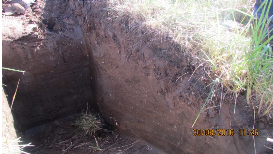
Abbildung 5: Deponie Spremberg-Cantdorf: Aufgrabung der Wasserhaushaltsschicht fünf Jahre nach Herstellung
