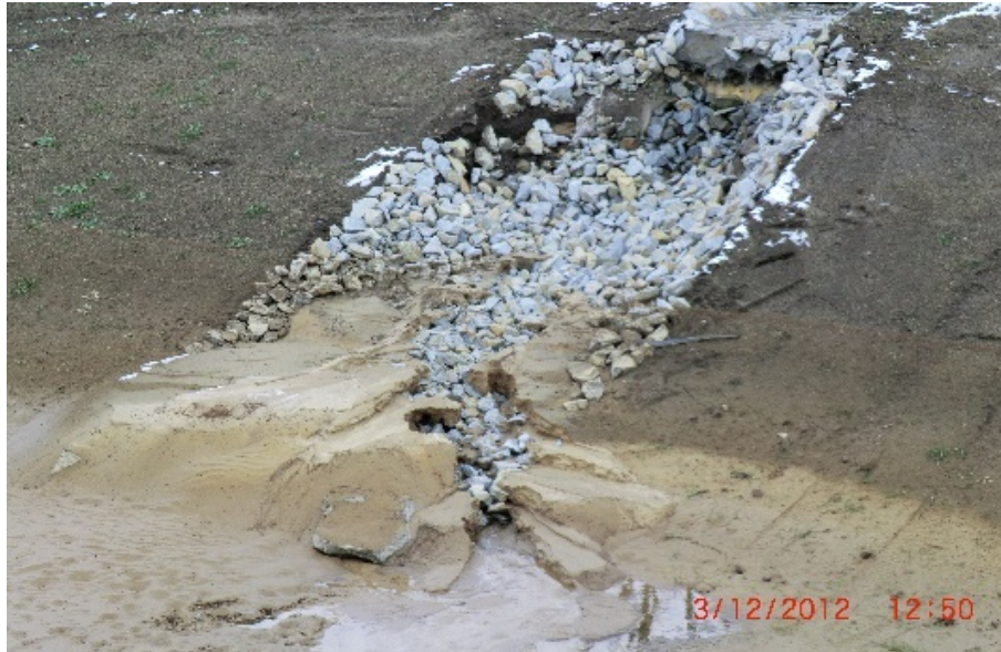
Abbildung 9: Deponie Spremberg-Cantdorf: Unterspülung und Abrutschen der gemauerten Regenwasserableitung in der Bauphase nach einem Starkregenereignis
