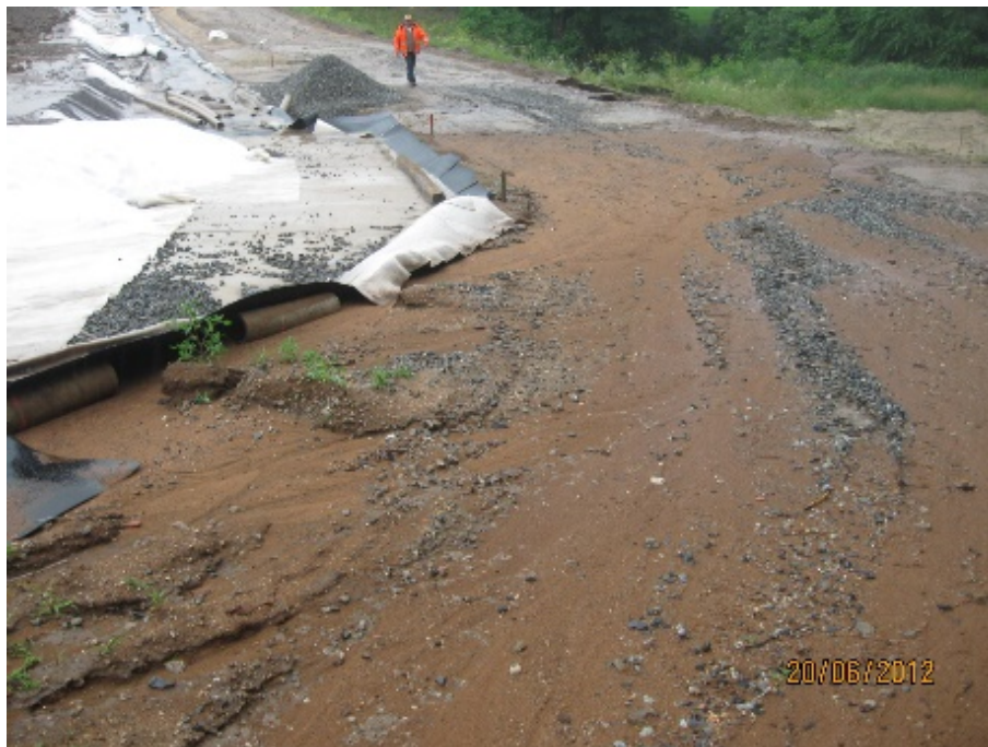
Abbildung 6: Deponie Spremberg-Cantdorf: Schaden in der Bauphase nach einem Starkregeneignis
