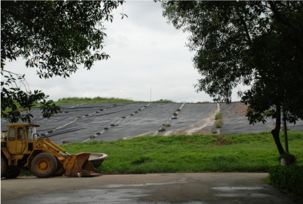
Abbildung 3: Partielle Abdeckung der Deponie Gò Cát mit lose aufgelegter Folie.
