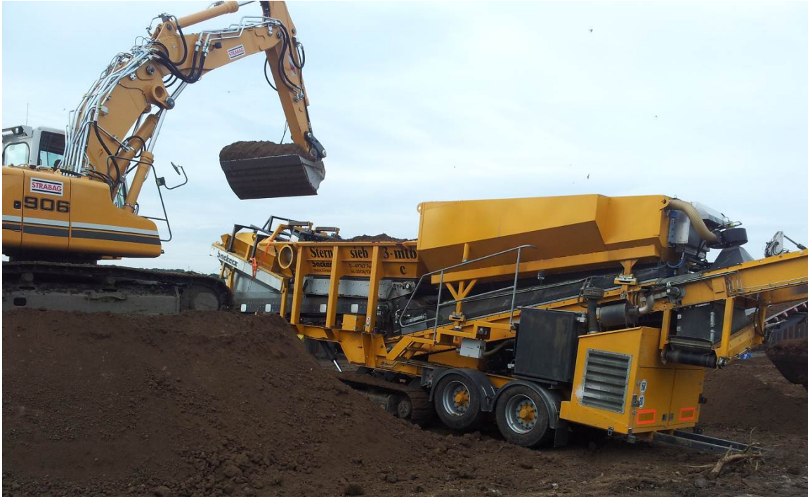
Abbildung 3: Sternsieb 3-mtbc bei der Bodenaufbereitung, Deichinstandsetzung an der Neuen Luppe bei Leipzig
