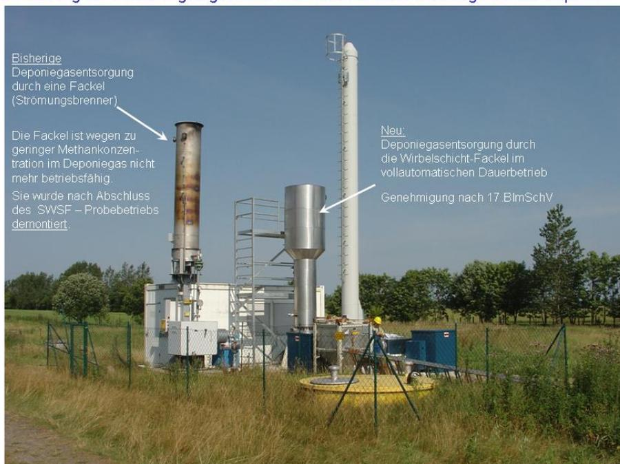
Abbildung 3: Umstellung der Deponiegasentsorgung auf die Wirbelschichtfackel
