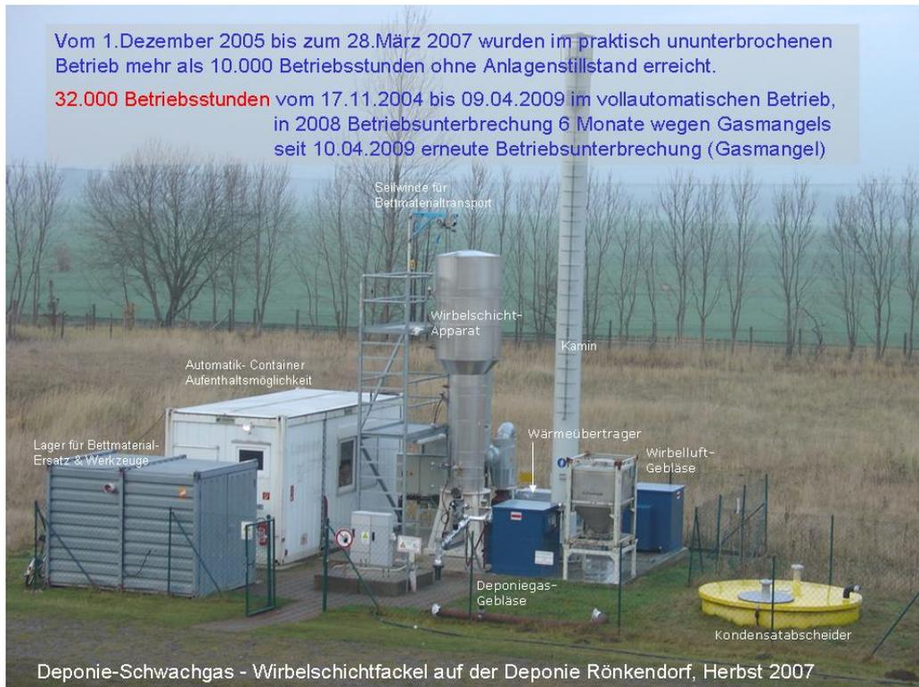
Abbildung 4: Gesamtansicht der Schwachgasfackel
