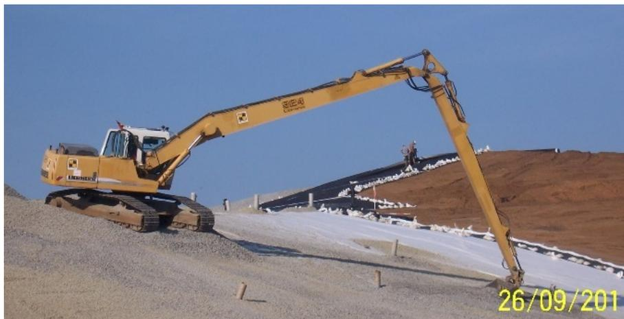
Abbildung 3: Einbau der mineralischen Entwässerungsschicht mittels Langarmbagger
