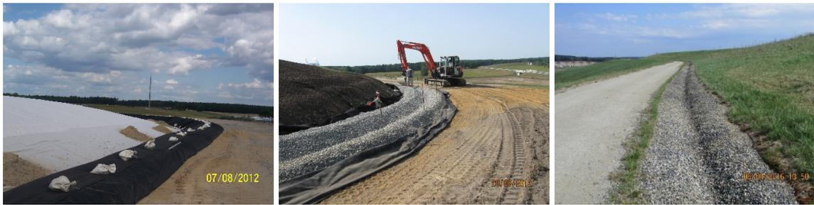
Abbildung 13: Deponie Spremberg-Cantdorf: Herstellung der Versickerungsrigole auf dem Deponiekörper
