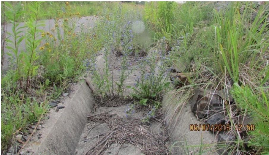
Abbildung 7: Teilweise zugewachsene Betonkaskade einer Betriebsdeponie
