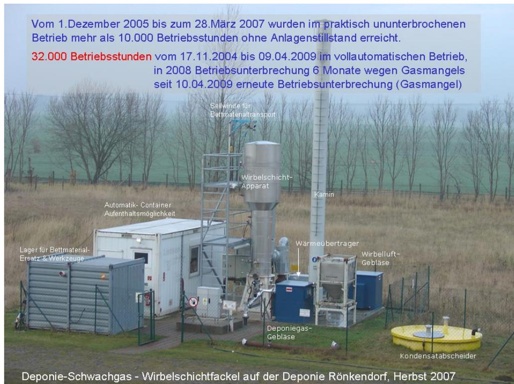
Abbildung 4: Gesamtansicht der Schwachgasfackel
