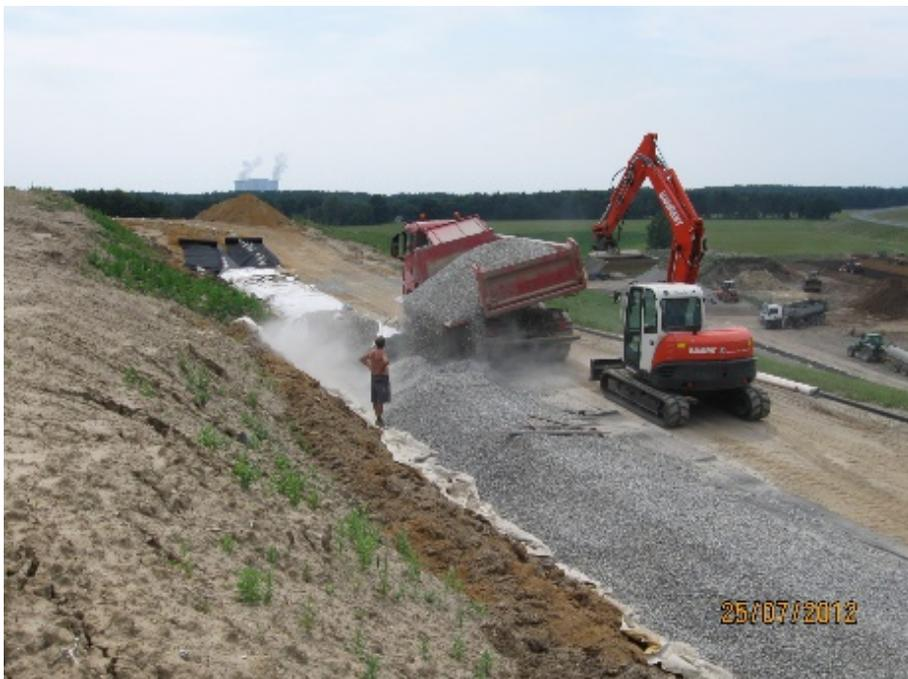
Abbildung 12: Deponie Spremberg-Cantdorf: Einbau der Versickerungrigole auf dem Deponiekörper
