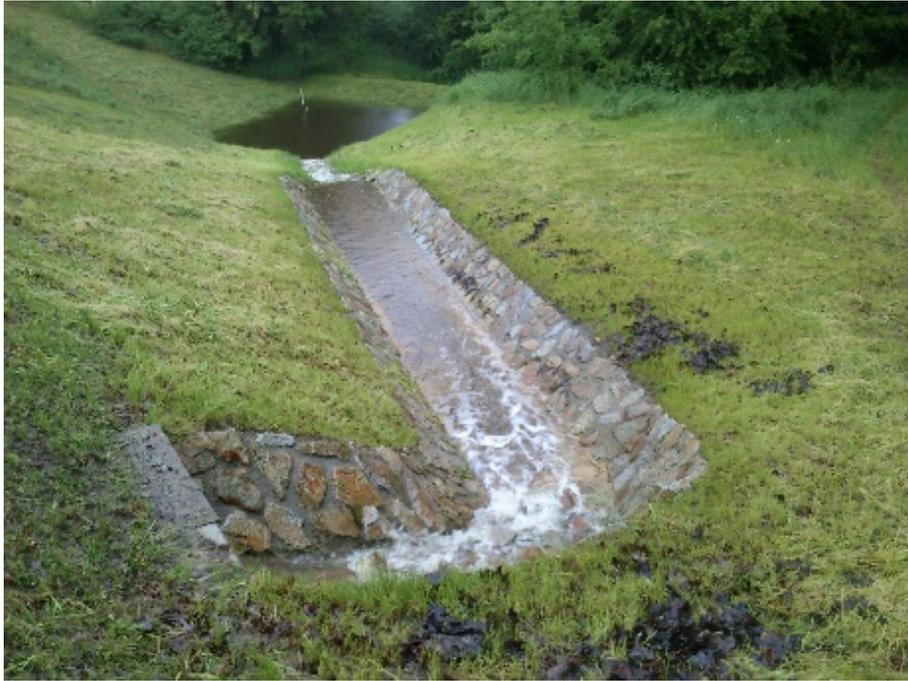
Abbildung 10: Deponie Spremberg-Cantdorf: Aus Naturstein gemauerte Absetzanlage
