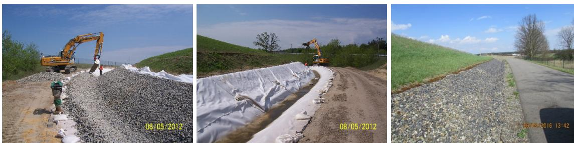
Abbildung 14: Deponie Spremberg-Cantdorf: Herstellung des Oberflächenwasserableitgraben
