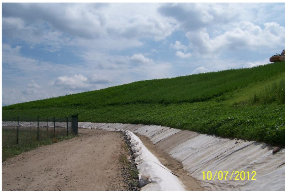
Abbildung 4: Schutz der fertiggestellten Entwässerungsgräben durch Vliesabdeckung
