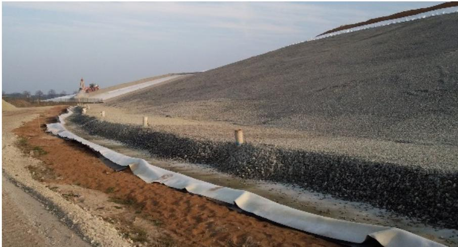
Abbildung 1: Aufbau einer mineralischen Entwässerungsschicht
