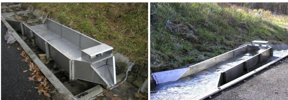
Abbildung 4: Flume zur berührungslosen Abflussmessung über Ultraschallsensoren (Deponie Langenlonsheim).
