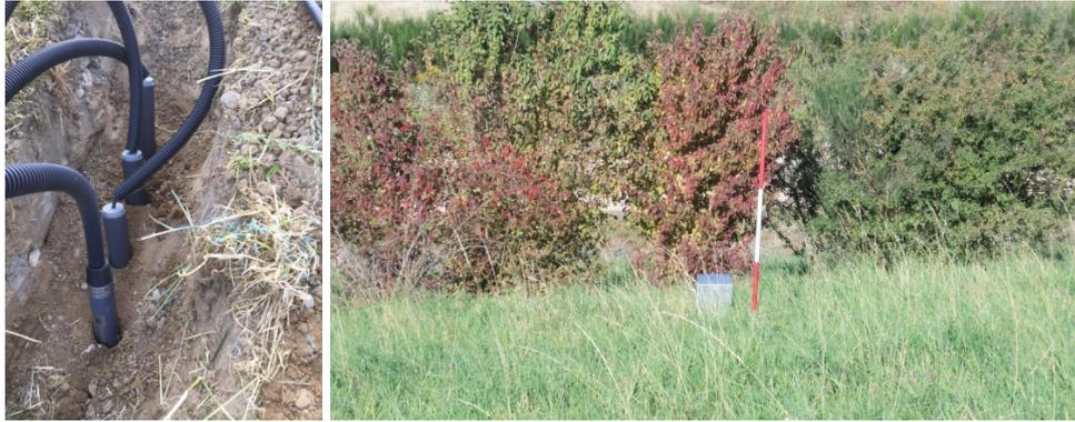
Abbildung 13: Errichtung eines bodenhydrologischen Messplatzes zur Überwachung der Frostschutzwirkung der oberen Abdeckschicht (links) und Zustand des Messplatzes heute (rechts) (Deponie Gröbern).
