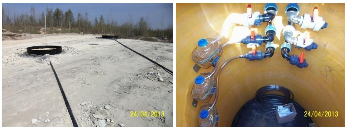
Abbildung 11: Einsatz von Sickerwasserfassungen in verschiedenen Schichten innerhalb der Abdeckschicht (links) mit Sickerwasserschacht (rechts) (Deponie Profen).
