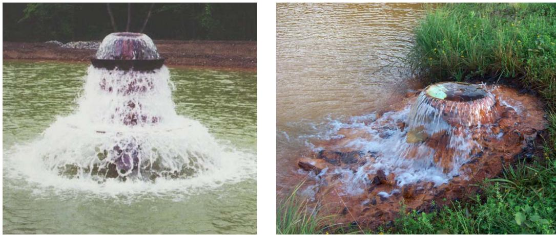
Obrázek 3: Príklady aeračných fontán na prekysličenie vôd.
