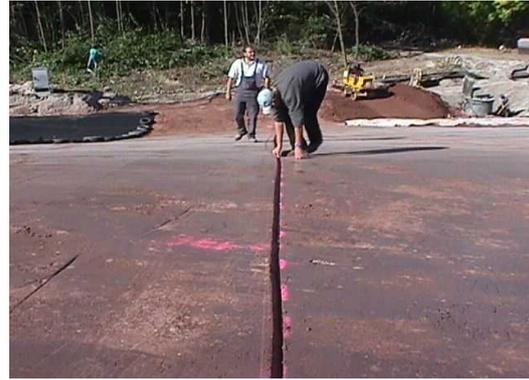
Abbildung 7: Die Kabel werden in Rillen eingelegt.
