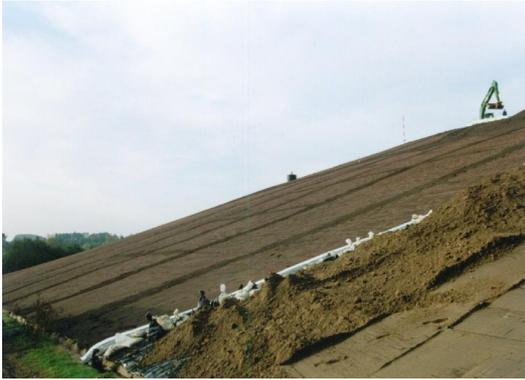
Abbildung 6: Die Kabel sind strangförmig im Auflager eingegraben.
