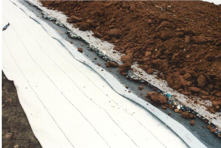
Abbildung 8: Die Kunststoffdichtungsbahn ist für die Funktionsprüfung im Testfeld freigelegt.
