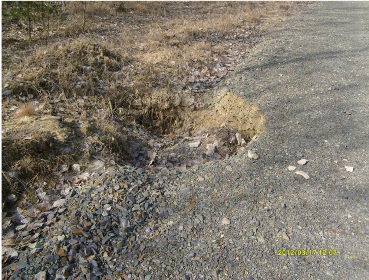
***Bild 13 Tagesbruch am Schotterweg bei Kontrollbohrung K314/02***
