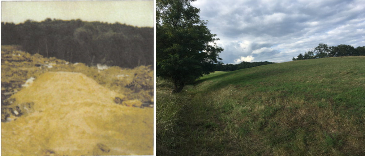
Abbildung 3: Zustand der Deponie Klausdorf vor und nach der Sicherung.
